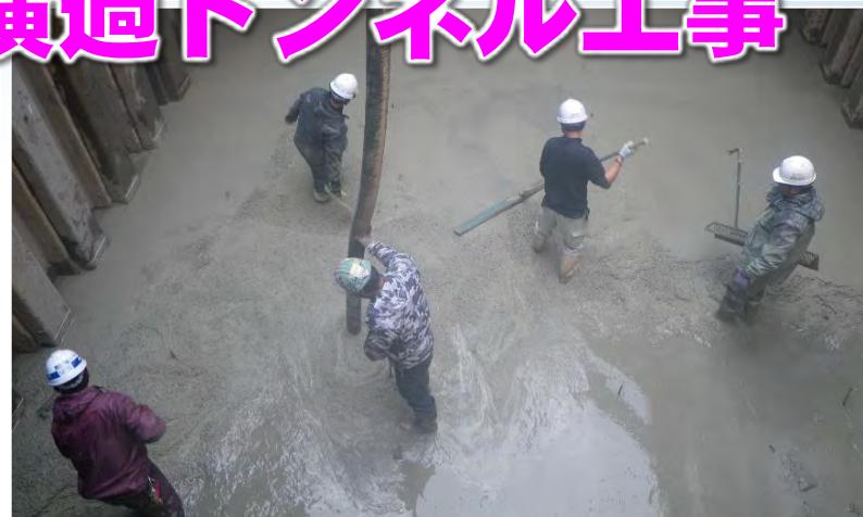
平成30年7月豪雨により被災した、末政川を横断する用水管の復旧工事。
