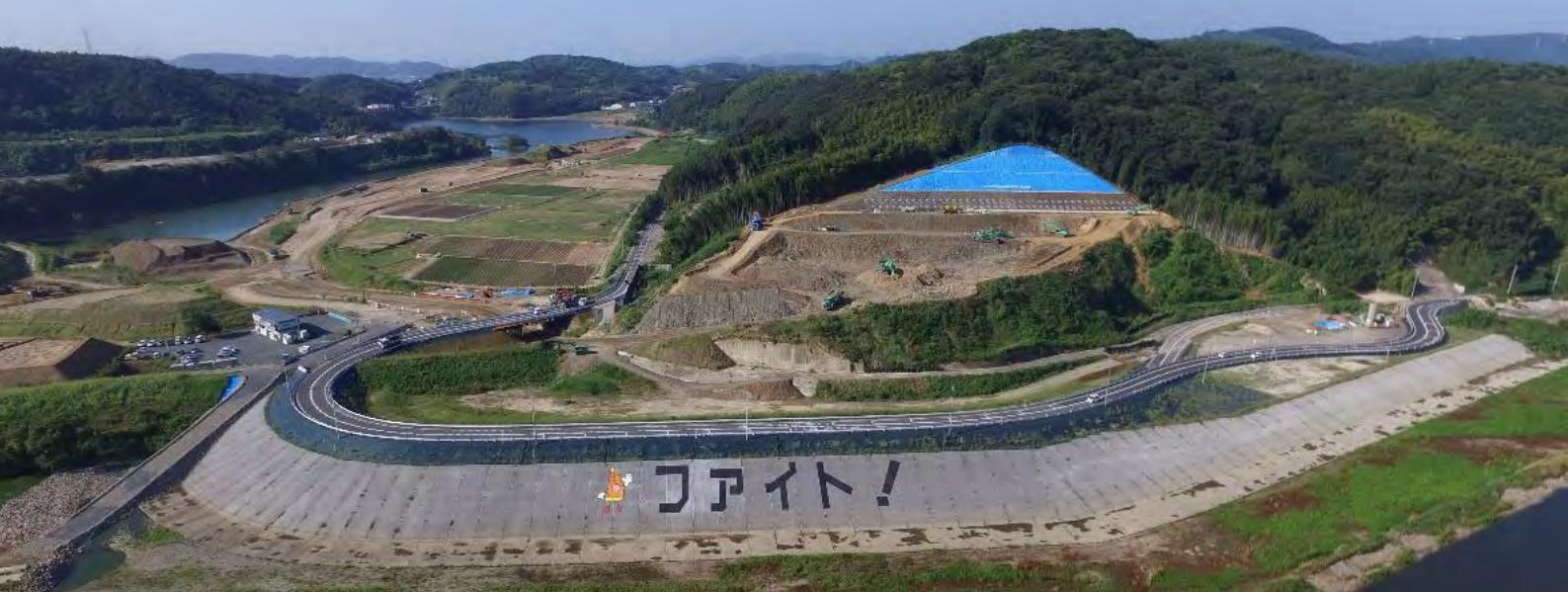
付替え後的小田川の川幅を確保するために、山を切り開き川にします。
