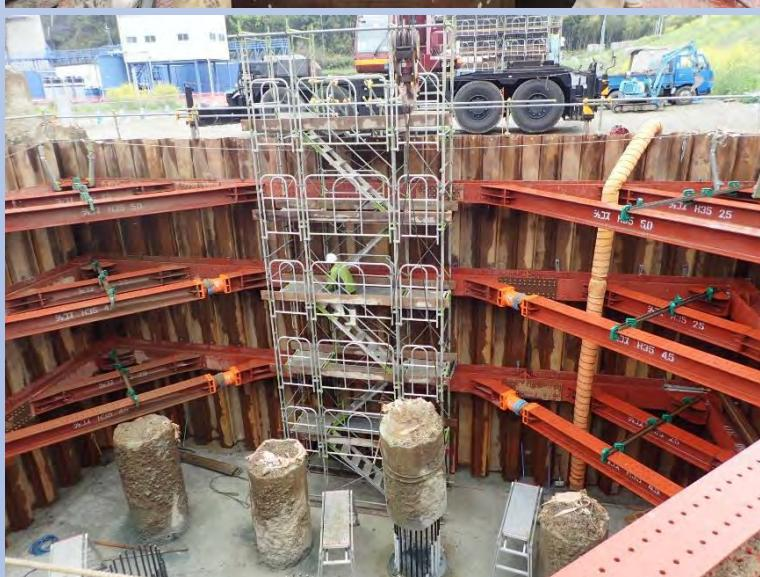
地盤を掘削した後、地上で組み立てた杭の鉄筋を地下に挿入。
