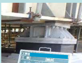
耐震補強工事一例
