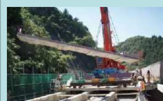
床版取替工事一例
