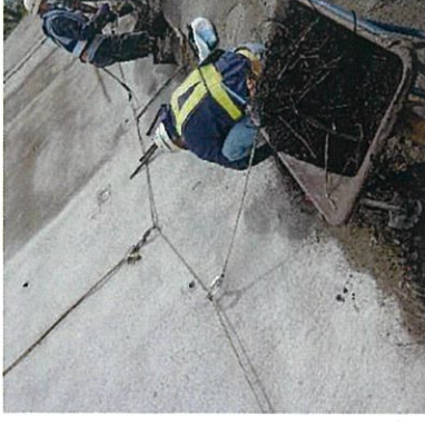
作業時 もなるべく 離隔を確保
