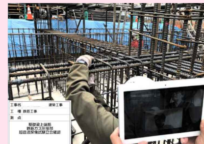
Webカメラを利用した遠隔検査
