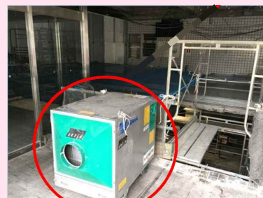
集塵機を設置し室内の換気を実施
