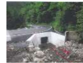
排水施設の整備
