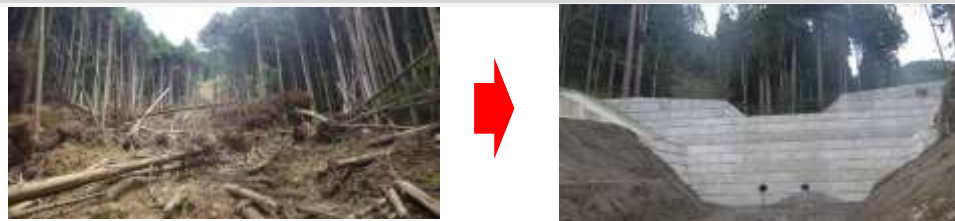
民有林直轄治山事業等による整備(福岡県朝倉市)
