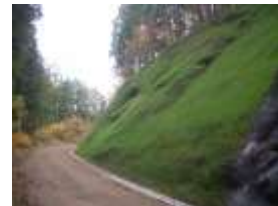
法面保護工の整備
