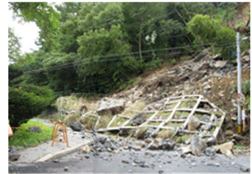
応急仮工事の事例 (仮設防護柵の設置)
