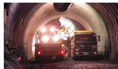
車両系機械による掘削作業
