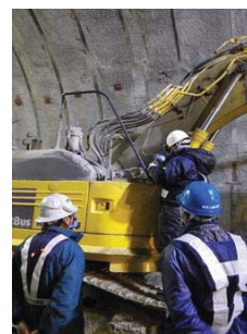
(3) 車両系機械を用いた測定
