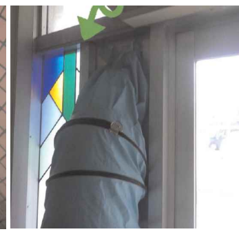
内装工事において、送風機及び冷却器を使った換気を実施
