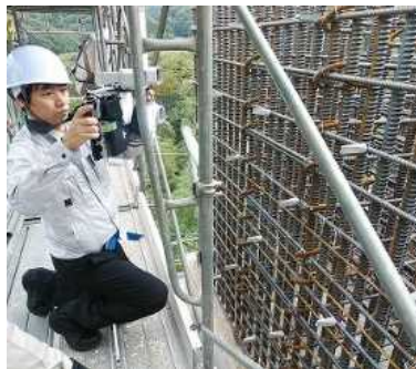
システムによる配筋検査
