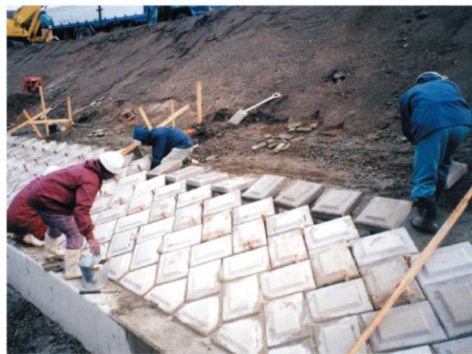
コンクリートブロックの設置作業状況
