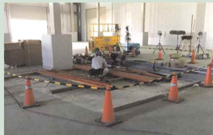
工事エリアの区画を設定して作業
