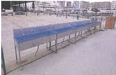
現場の手洗い場所の増設
