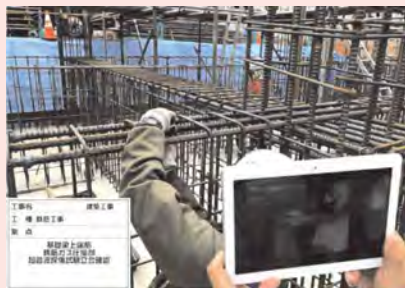
Webカメラを利用した遠隔検査
