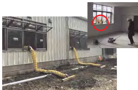
送風機を稼働し、埃を外部へ排出
