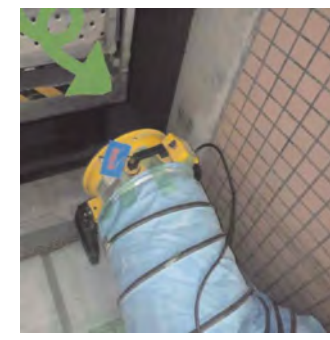
内装工事において、送風機及び冷却器を使った換気を実施
