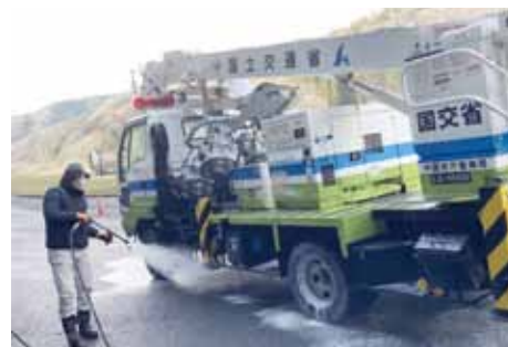
照明車消毒及び回送作業
