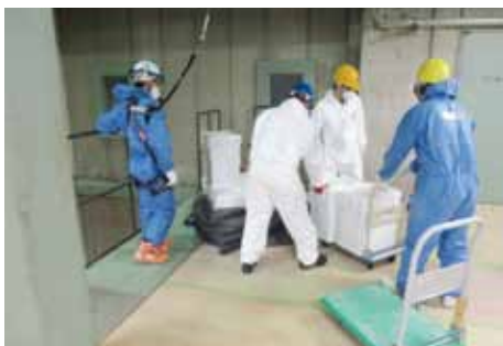
焼却作業に関連した玉掛け作業等
