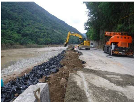
大型土嚢の製作・設置
