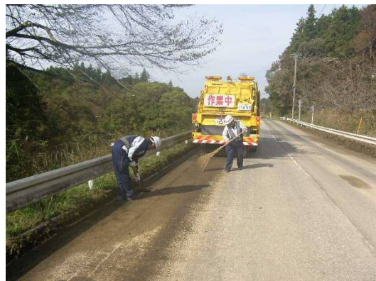
路面清掃（散水）
