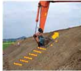
ICTバックホウの刃先等の施工履歴データを記録
