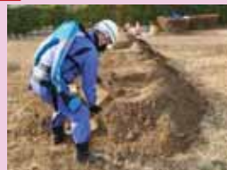
パワーアシストスーツを活用したガレキ撤去の例
