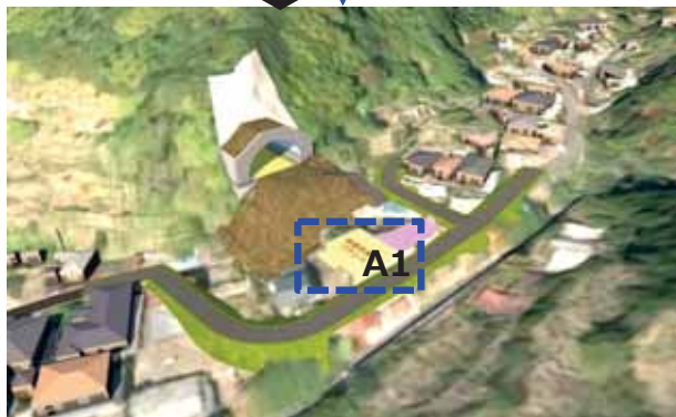
2) 橋台の施工に備え、地盤改良を実施
