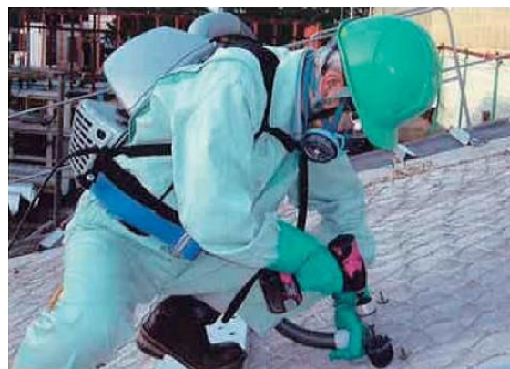
集じん回収(高性能真空掃除機)
