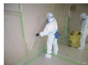
養生シートの撤去
