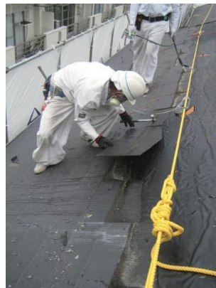
スレートの除去
