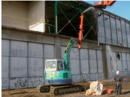
湿潤化の例（散水）
