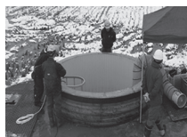
農林水産大臣賞 腐食した「集水井」の内巻補強工法—老朽化した集水井を容易・迅速に補強— 国立研究開発法人農業・食品産業技術総合研究機構 ほか
