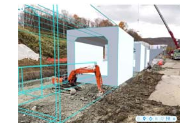
掘削作業時にARと比較
